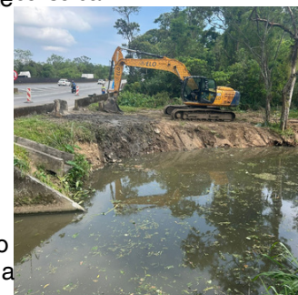
Ações emergenciais com máquinas reforçam o sistema de drenagem do Vale Verde.
